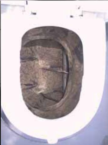
Cámara de compostaje con aserrín debajo del sanitario
